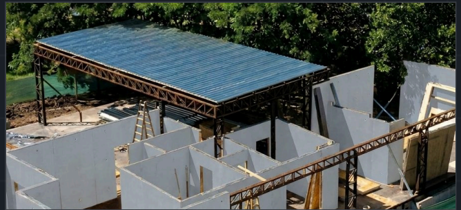
Montaje en seco — paneles autoportantes en obra
