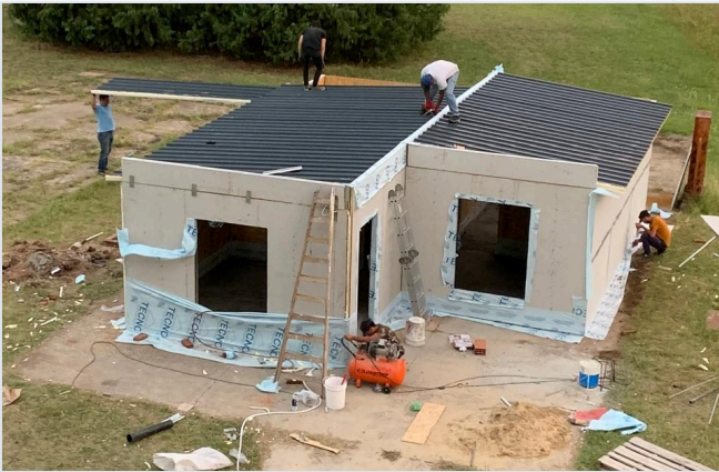
Montaje en seco documentado desde altura: panelería autoportante posicionada sobre platea, lista para techos.
