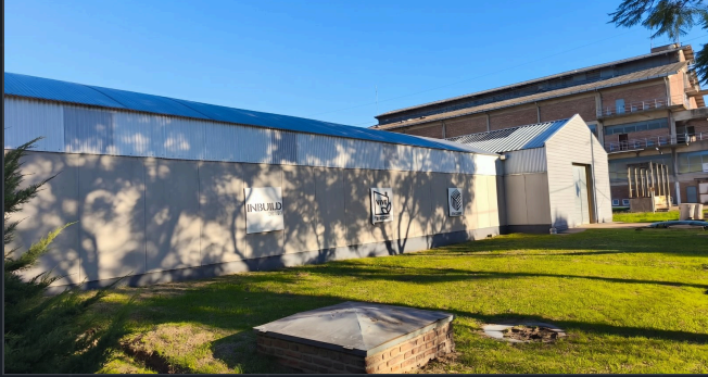
Planta de fabricación · Parque Industrial Zárate
